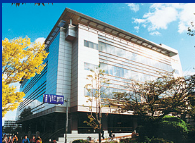
付属図書館本館（新館）
